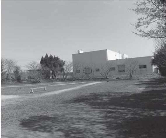
中ノ迫公園からの処理施設
